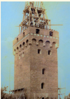
Rekonstruktionsmaßnahme um 1900 des ehemaligen Walmdaches
